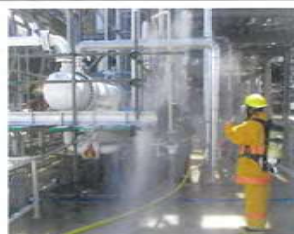
ทีมฉุกเฉิน เข้าปิดวาล์วเพื่อหยุดการรั่วไหล
